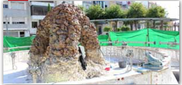
Obres a la font de la Mera
