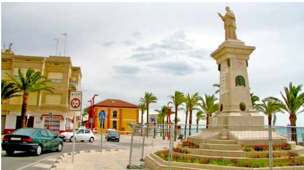
En el monumento han aparecido grietas
