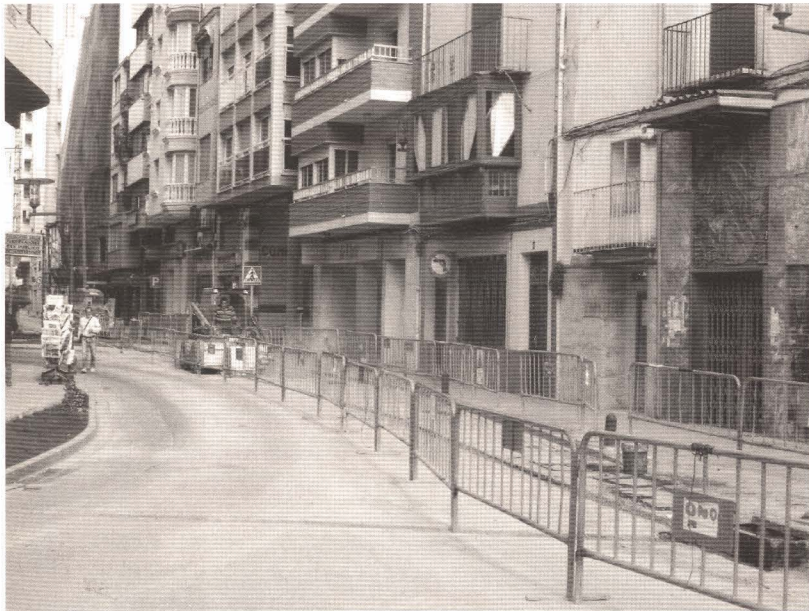
Les obres de cablejat d'Ono, a punt de finalitzar
