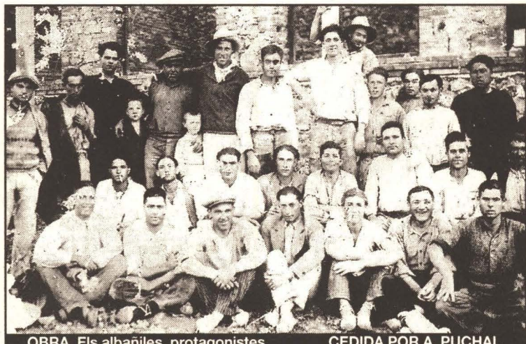
OBRA. Els albañiles, protagonistes.
