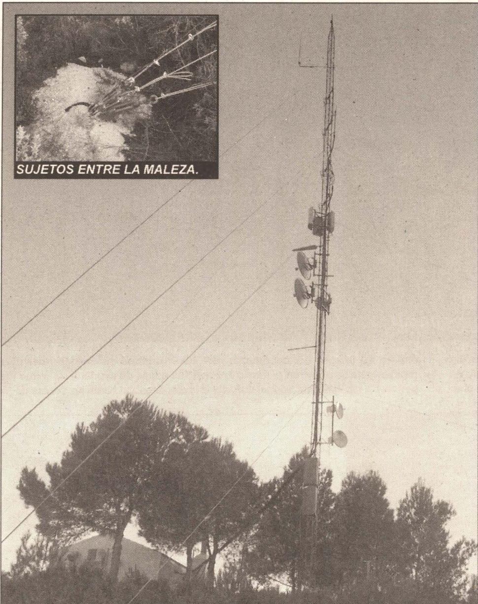
TENSORES. Sin ningún tipo de señalización y carentes de medidas de seguridad
