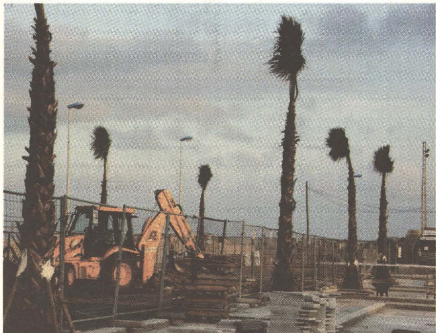
Lo que no se ve. Además de las mejoras visibles, la COPUT ha aumentado la capacidad de absorción de aguas pluviales procedentes del casco urbano.
