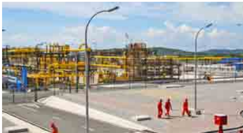
Vista de la planta terrestre de operaciones Ignacio Pérez
