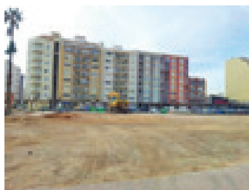
En el PAI de Fora Forat se han derribado las últimas casas existentes con lo que se ha mejorado el entorno y garantizado la salubridad de los vecinos (Foto PAI Fora Forat)
