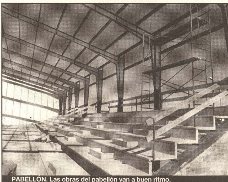
PABELLÓN. Las obras del pabellón van a buen ritmo.
