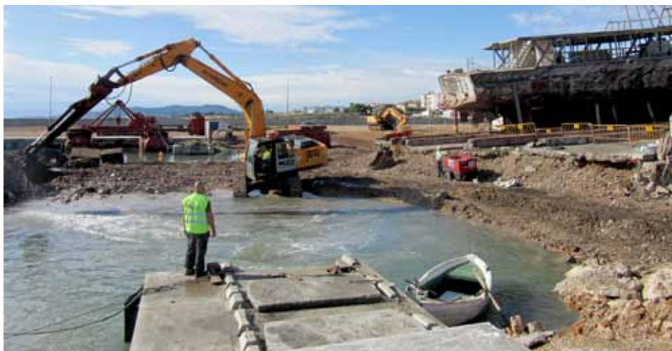
Trabajos de demolición de las vías del carro del varadero
