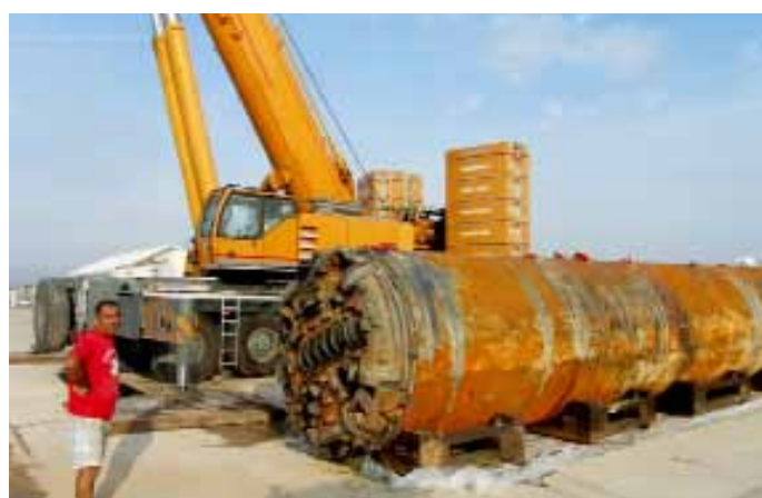
Tuneladora del Proyecto Castor sobre el muelle transversal
