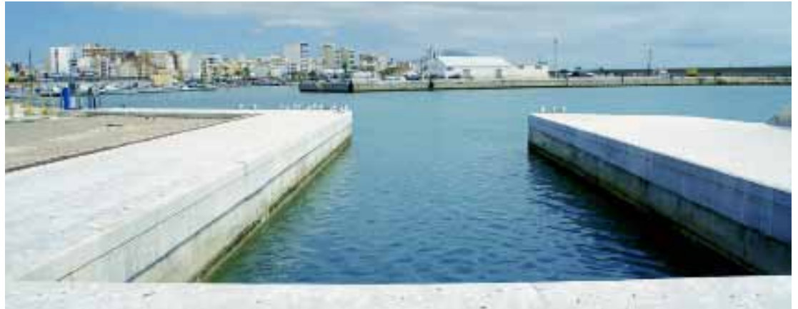
El puerto tendrá nuevas instalaciones
