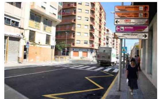
La avenida Libertad, ya asfaltada
