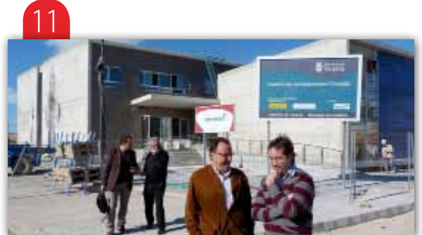
Les obres del Vinalab, a punt de finalitzar
