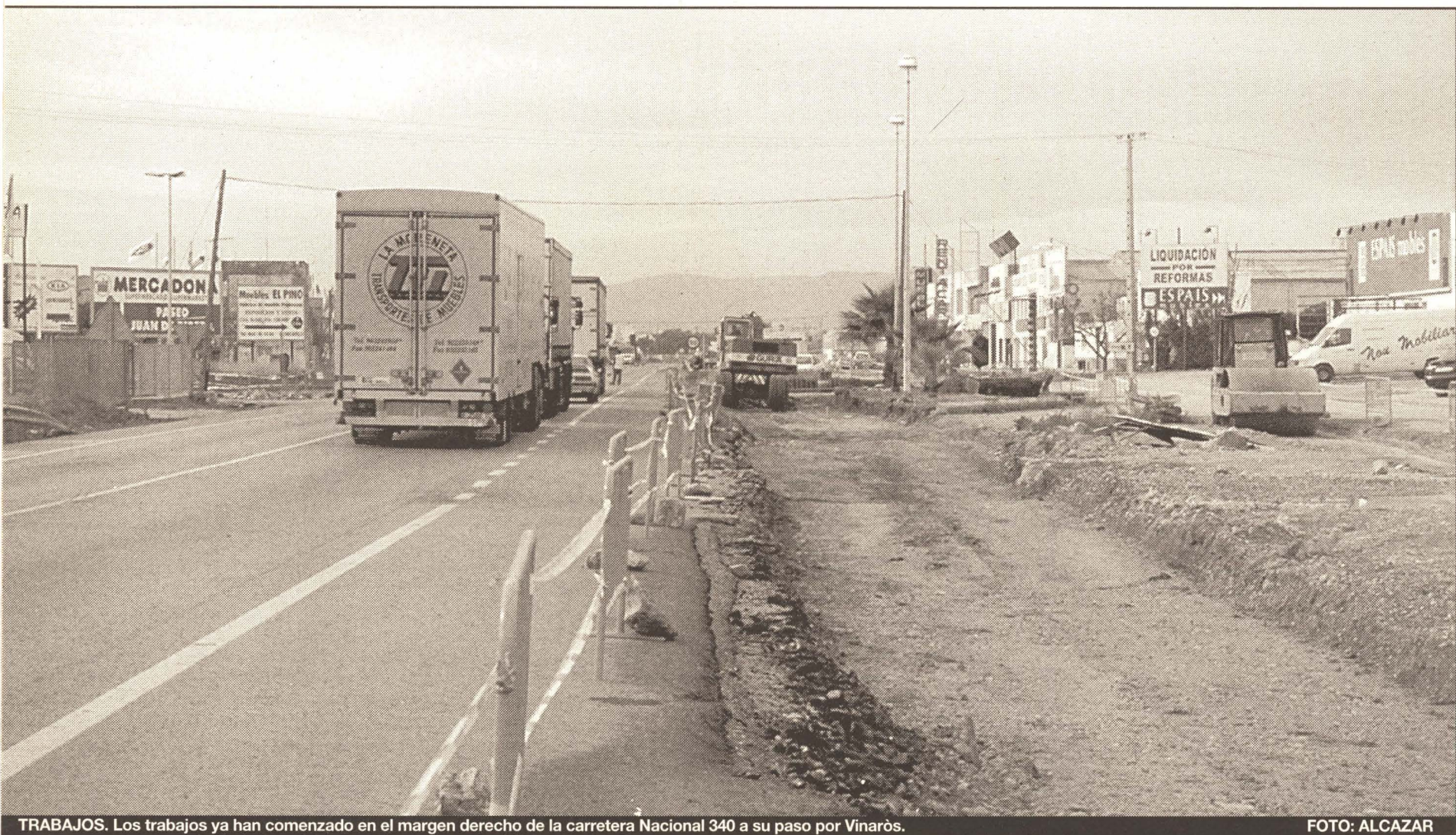
TRABAJOS. Los trabajos ya han comenzado en el margen derecho de la carretera Nacional 340 a su paso por Vinaròs.
