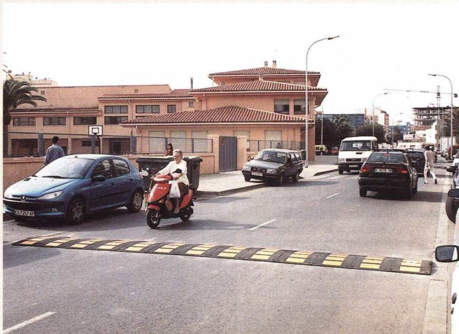
A les avingudes Llibertat i Tarragona s'han instal·lat reductors de velocitat. Foto: Arts
