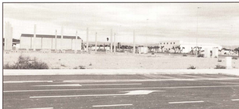
En la primera fase se construyen naves industriales. Foto: A. Alcázar
