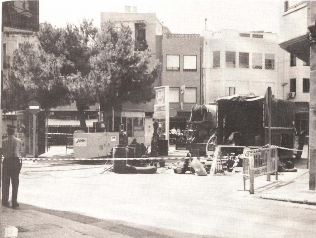
Pl. Tres Reyes, los depósitos de la antigua gasolinera se taponaron con hormigón. Los trabajos se efectuaron los días 16 y 19 de julio. Foto: A. Alcázar
