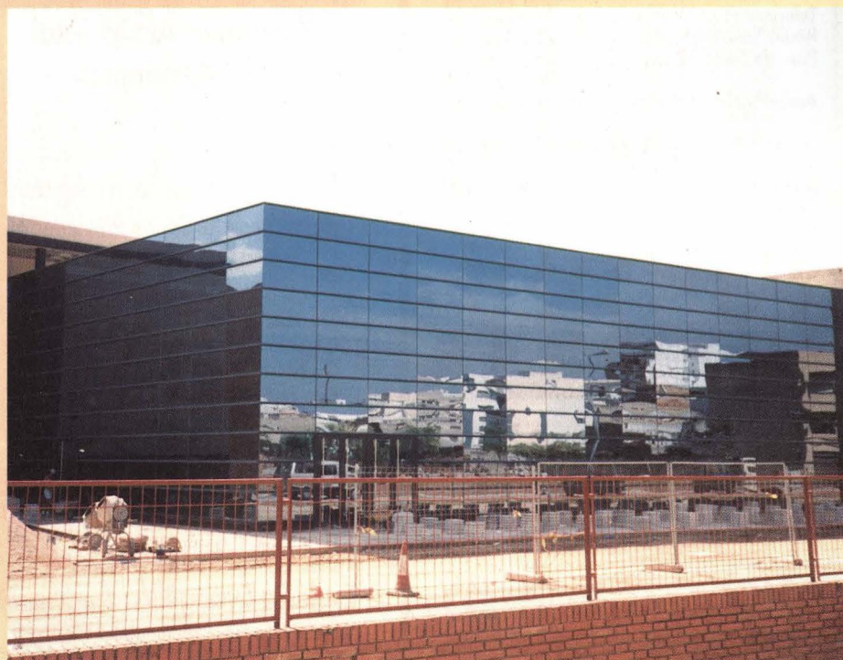
Molt avançades les obres del Palau de Justícia.
