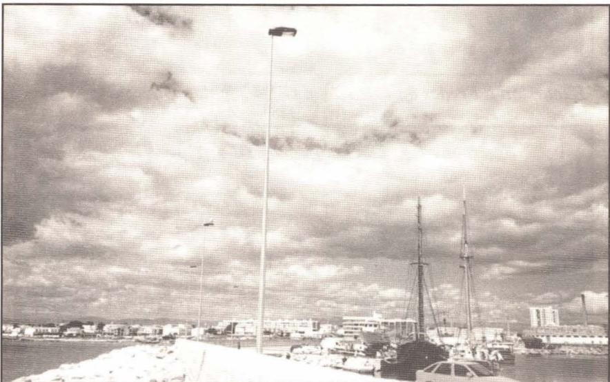
Nuevo aspecto del dique de Poniente. Foto: A. Alcázar
