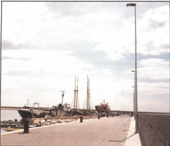
▲ S'han instal·lat faroles al contramoll
