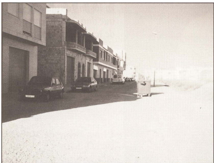
La calle J. Sebastián Farga, entre María Auxiliadora y Camí Fondo, el asfaltado está muy deteriorado y las aceras a tramos en no muy buen estado, la calle no tiene muchos años. Foto: A. Alcázar
