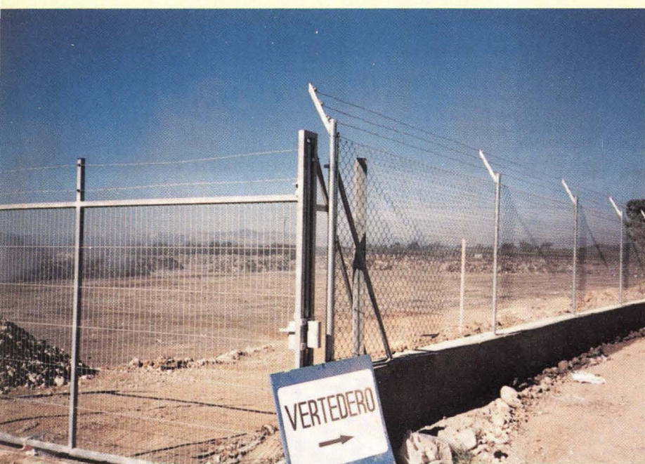
A l'abocador municipal s'han instal·lat tanques i dues portes. Foto: A. Alcázar
