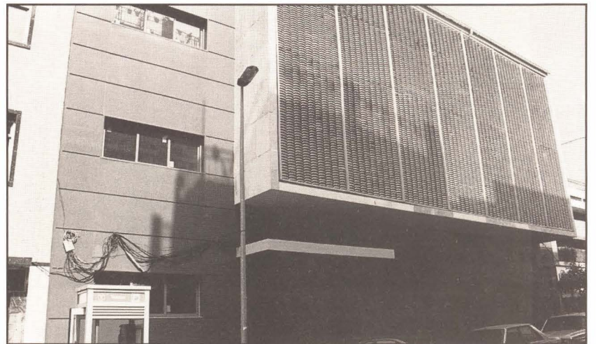
La fachada y el interior del Centro de Salud de la calle Arcipreste Bono ya han sido remodeladas. Tras ello se dotará de nuevo mobiliario. Esperemos que antes de finalizar el año sea inaugurado.
