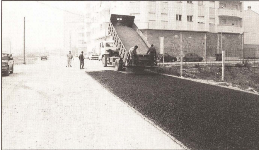
La Brigada de Obras del Ayuntamiento, acondicionó la Avda. Pablo Ruíz Picasso. Foto: Difo's
