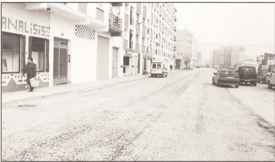
Riego asfáltico en la Avda. Pablo Ruíz Picasso. Foto: Difo's
