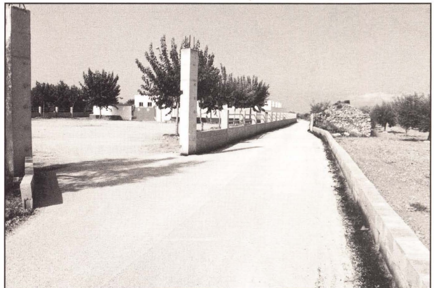
La Brigada de obras de la Concejalía de Agricultura ha asfaltado el camino que va desde la N-232 hasta el Tentadero de la Peña Taurina
