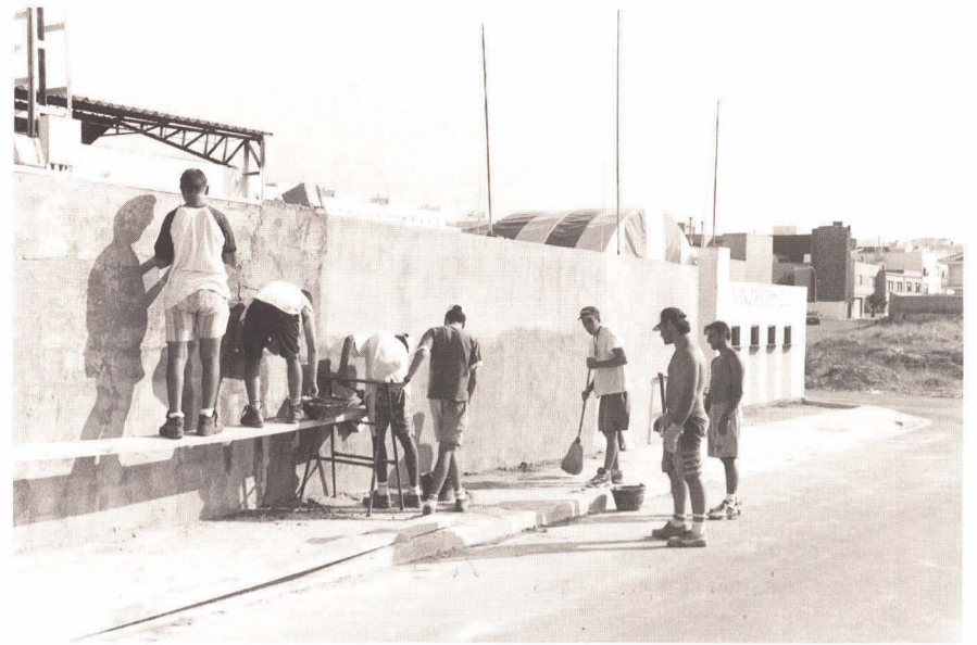
Trabajos en el Campo Cervol. Foto: Reula
