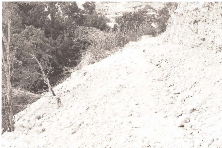
Un aspecto de las obras
