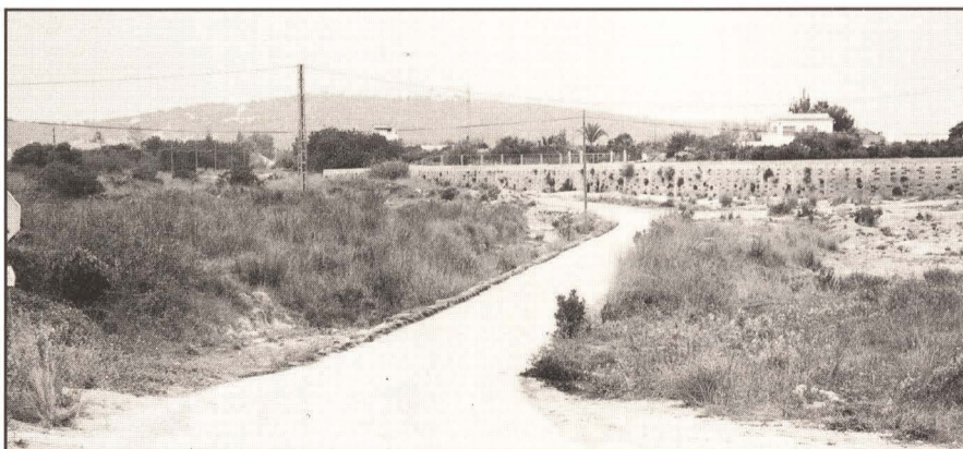
Continúa el asfaltado de caminos en el término municipal de Vinaròs.
