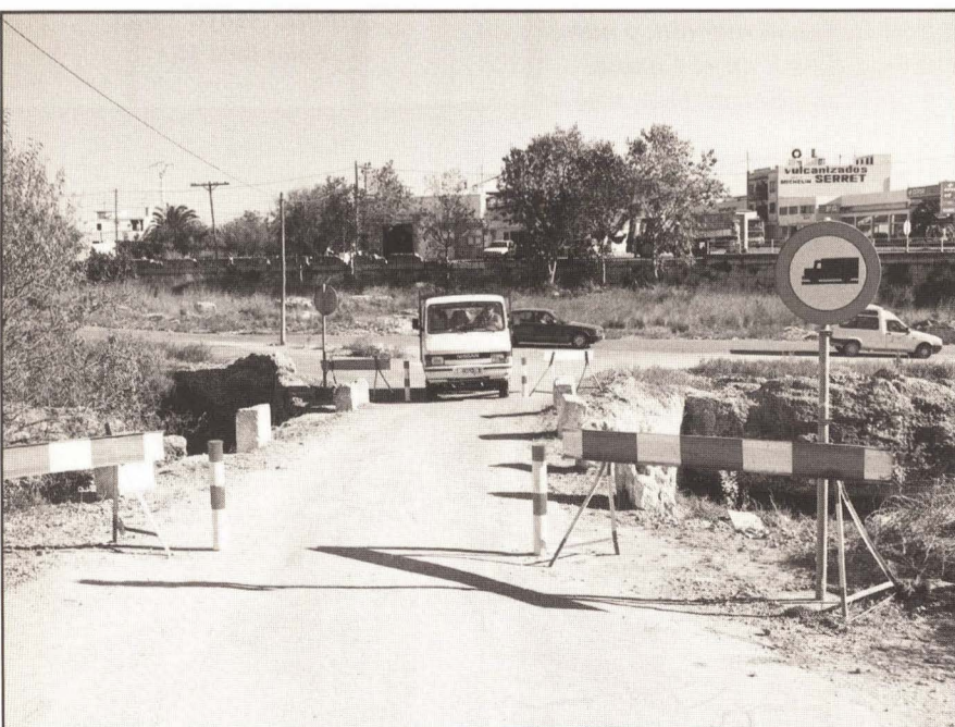
"Nuevas señales" en el Pont Romà para limitar el paso de camiones, dado que no obedecían la señal prohibitiva de su paso.
