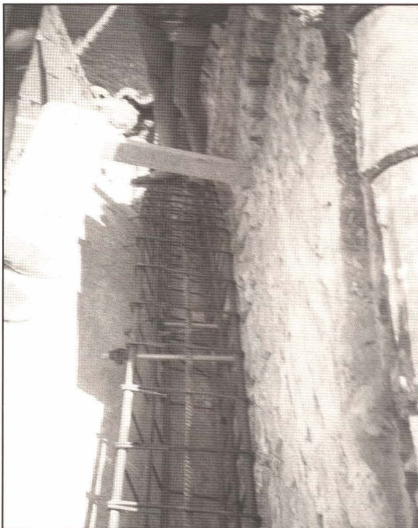
Armadura y anclaje del arco con la bóveda
