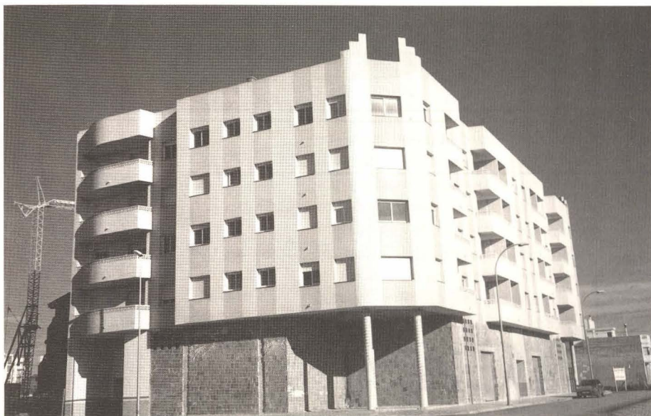
EDIFICIO NEPTUNO. Avda. Picasso, 42 - VINARÒS
