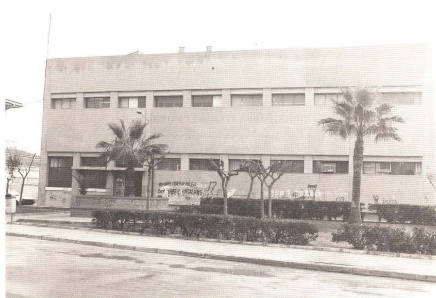
Se están modernizando los equipos de la central analógica
