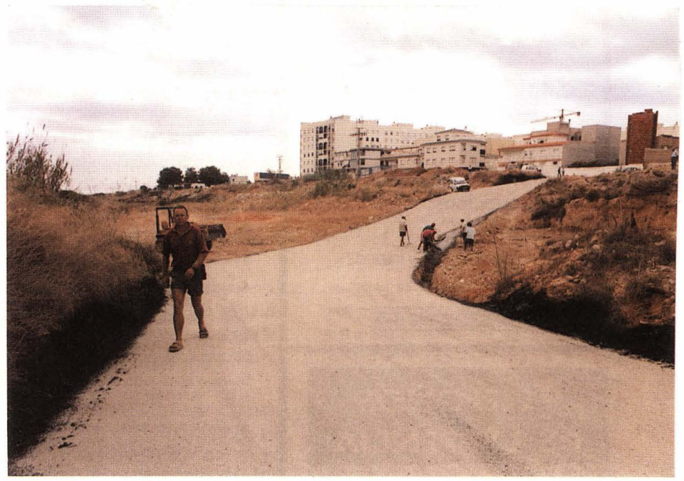
Así ha quedado el camino que cruza el Cervol, pavimentado por la brigada municipal. Foto: Reula
