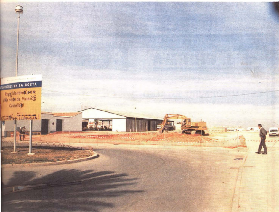
Han empezado las obras de prolongación del paseo. Foto: Reula
