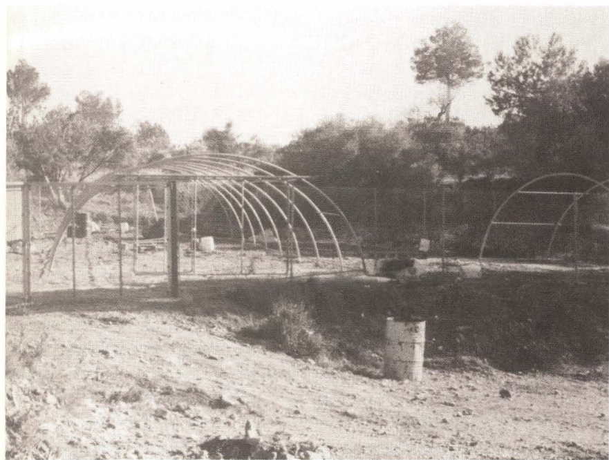
Panoràmica de las obras de construcción del insectario en el Puig de Vinaròs
