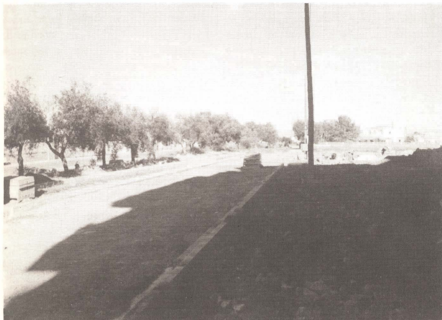
La Avenida Barcelona en obras de ampliación y nueva apertura de calle. Foto: Reula
