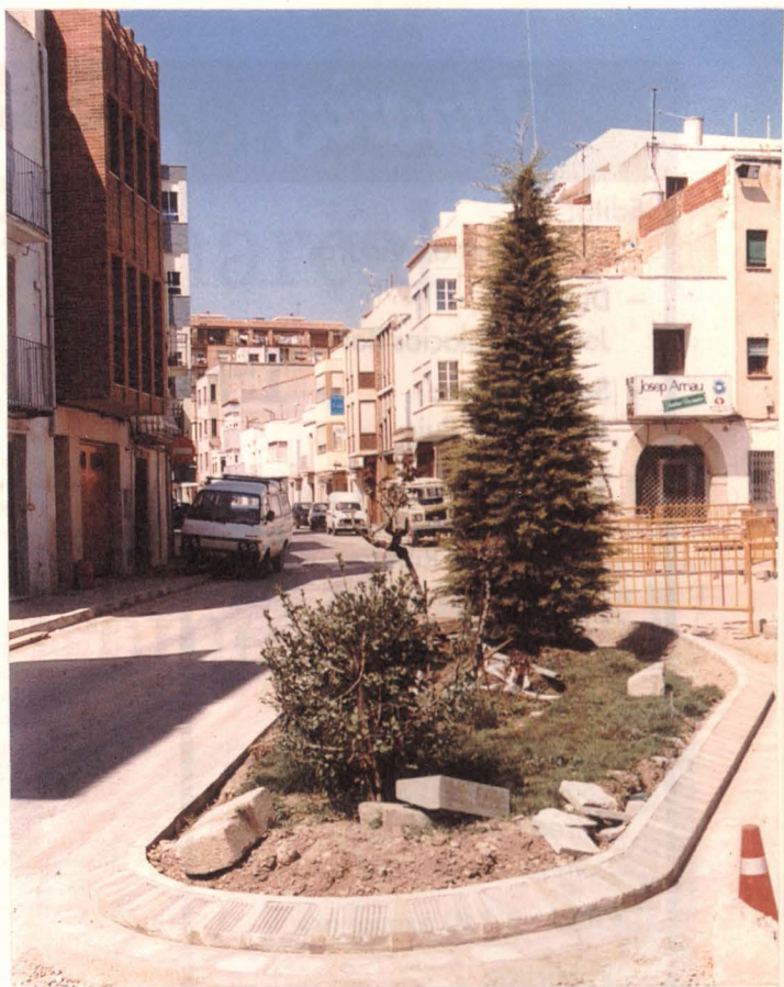
S'estan remodelant les voreres del carrer Pont. Foto: Reula
