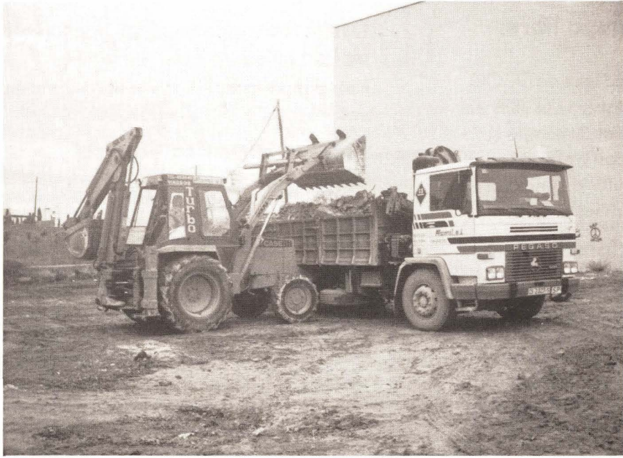
Se ha empezado la limpieza del solar para la construcción del nuevo edificio de la Banda de Música La Alianza. Foto: Reula
