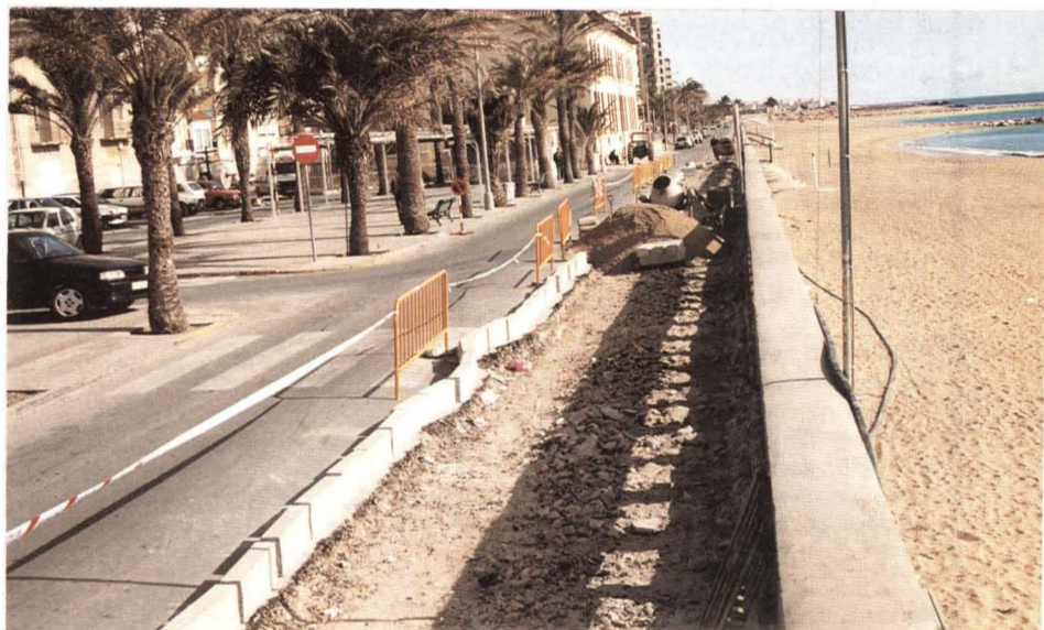
Han començat les obres de les voreres del Passeig Marítim. Foto: Reula
