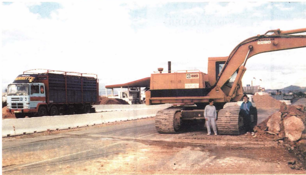
Han comenzado ya las excavaciones en la N-340 para el subterráneo que debe cruzarla. Foto: Reula
