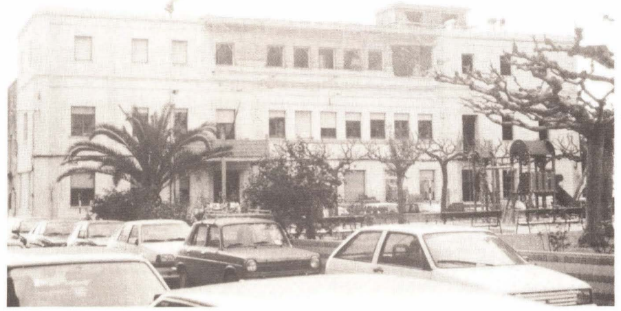
Están casi terminadas las obras en los Juzgados en donde se ubicará el nuevo Juzgado nº 3. Foto: Reula
