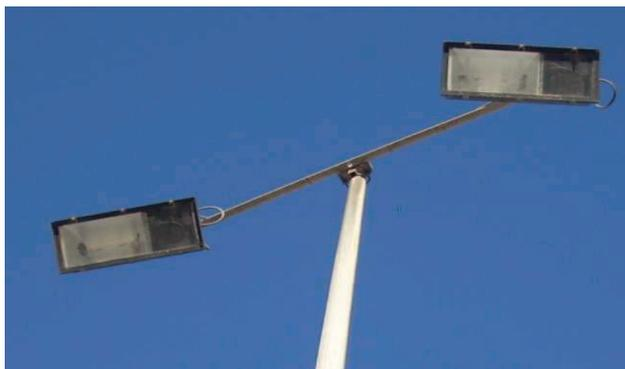
Imagen 16. Lámparas de halogenuros metálicos (exterior)
