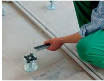
Encastres de los pedestales con los travesaños
