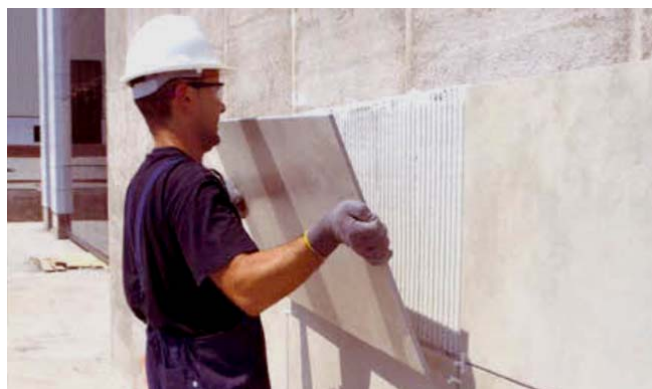
Instalación de fachada aplacada en capa fina
