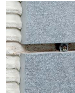
Detalle del sistema de fijación
