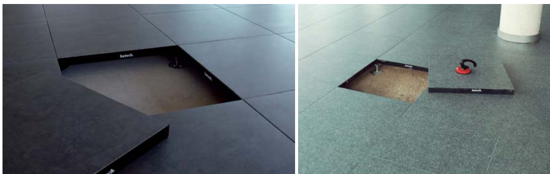
Instalación de suelos técnicos. Butech
