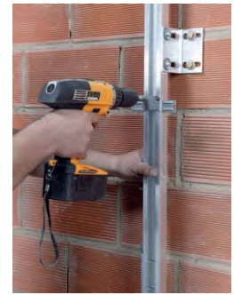
Instalación del anclaje sobre el perfil vertical
