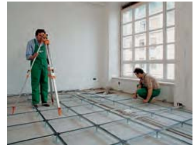
Puesta en cota de la estructura
