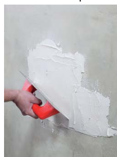
Aplicación del cemento cola sobre soporte
