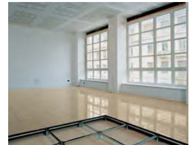
Acabado de los paneles
