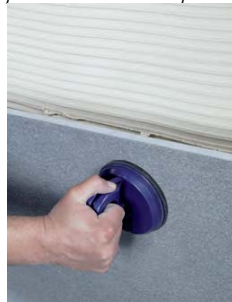
Instalación de la baldosa cerámica
