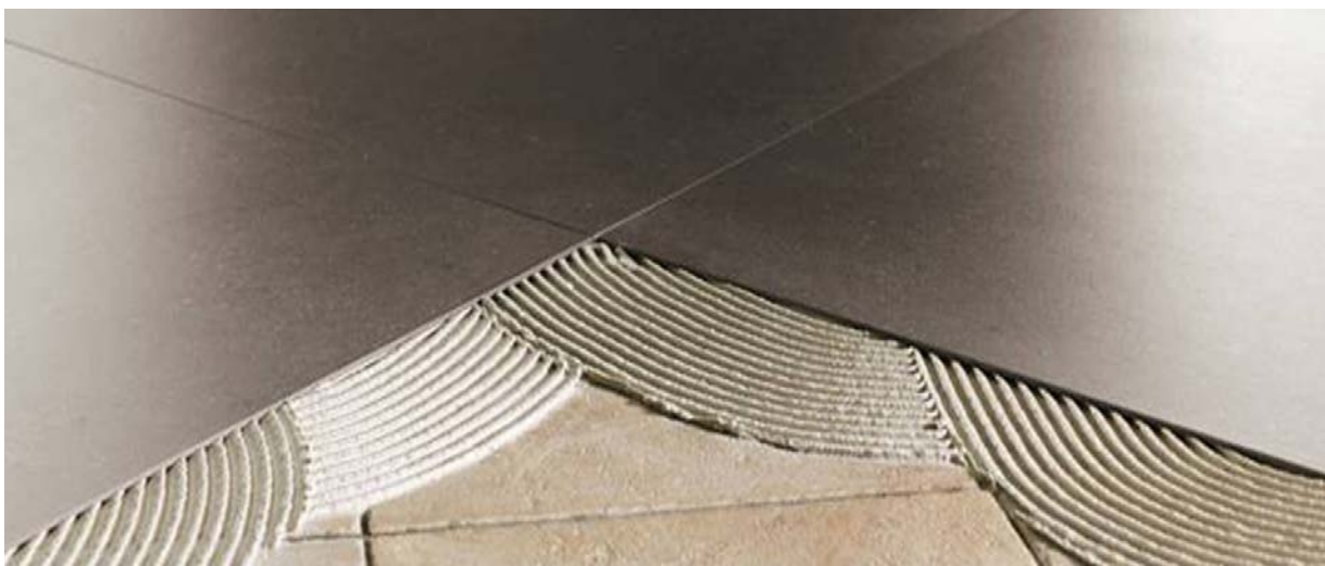
Instalación de lámina cerámica sobre soporte existente
