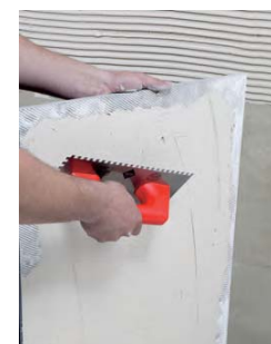
Doble encolado en el dorso de la baldosa
