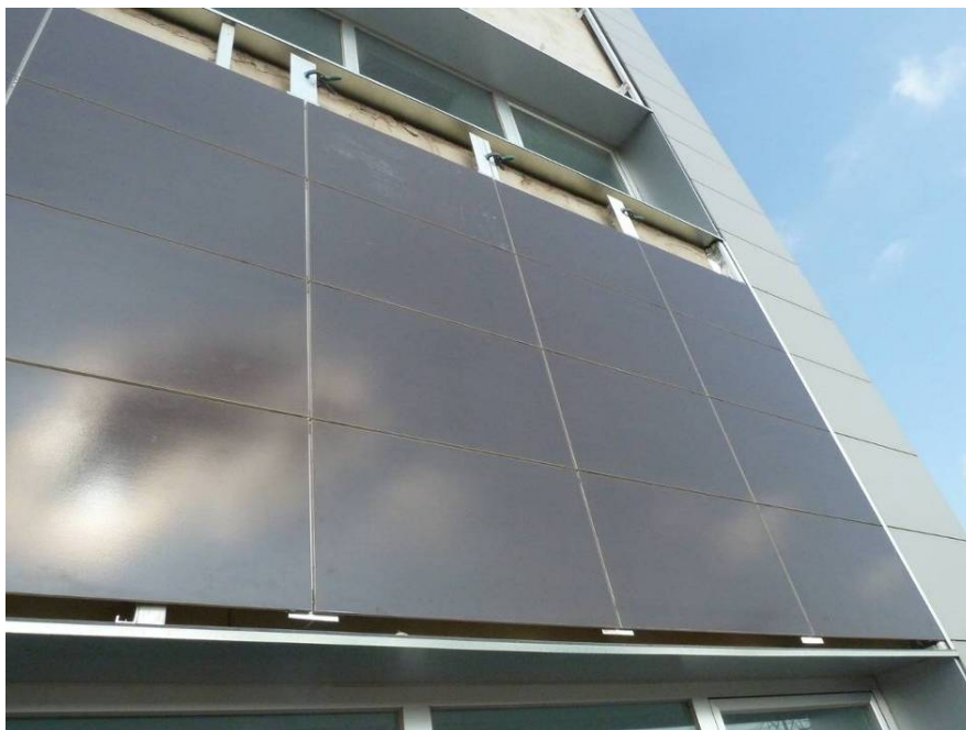
Instalación de Fachada ventilada Reflectiva en edificio CIES. KERABEN- ITC
