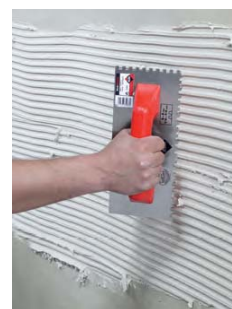
Peinado del cemento cola sobre el soporte
