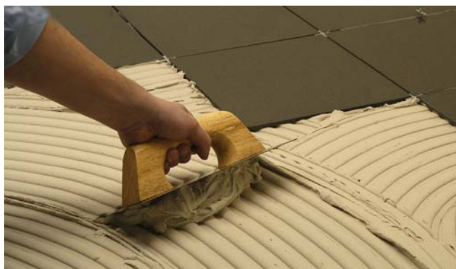
Instalación baldosa cerámica en capa fina
