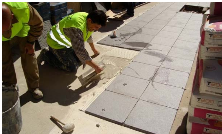
Instalación de acera cerámica. TAU cerámica
