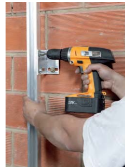
Instalación del perfil vertical sobre la ménsula
