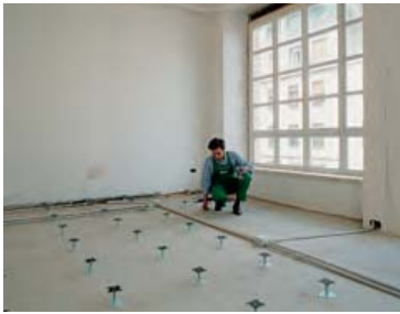
Posicionar los pedestales
