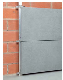
Colocación de hiladas superiores.
