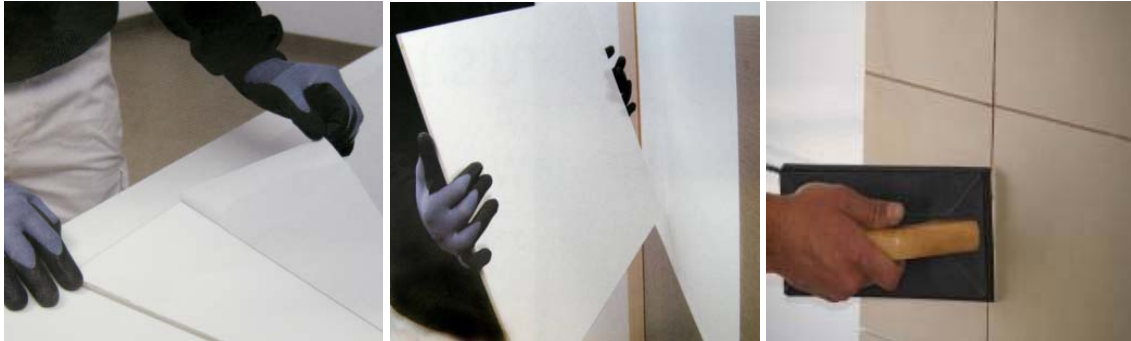
Imágenes de Rehabilitación mediante sistemas Wandefix. Wandegar
