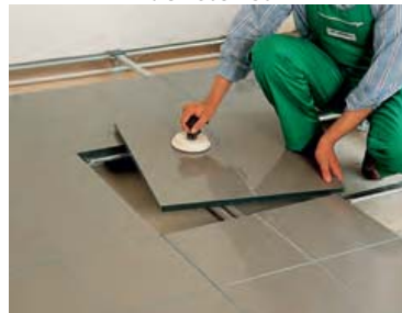
Instalación de los paneles
