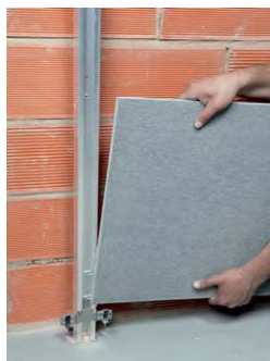
Instalación de la primera hilada sobre las garras
