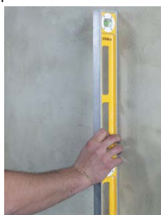
Comprobar la planeidad del soporte
