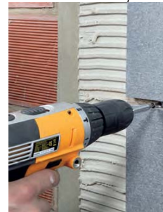
Apriete del anclaje de seguridad
