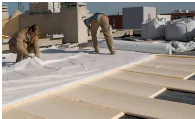
Componentes e instalaciones de un sistema de cubierta invertida. Fuente AIPEX
