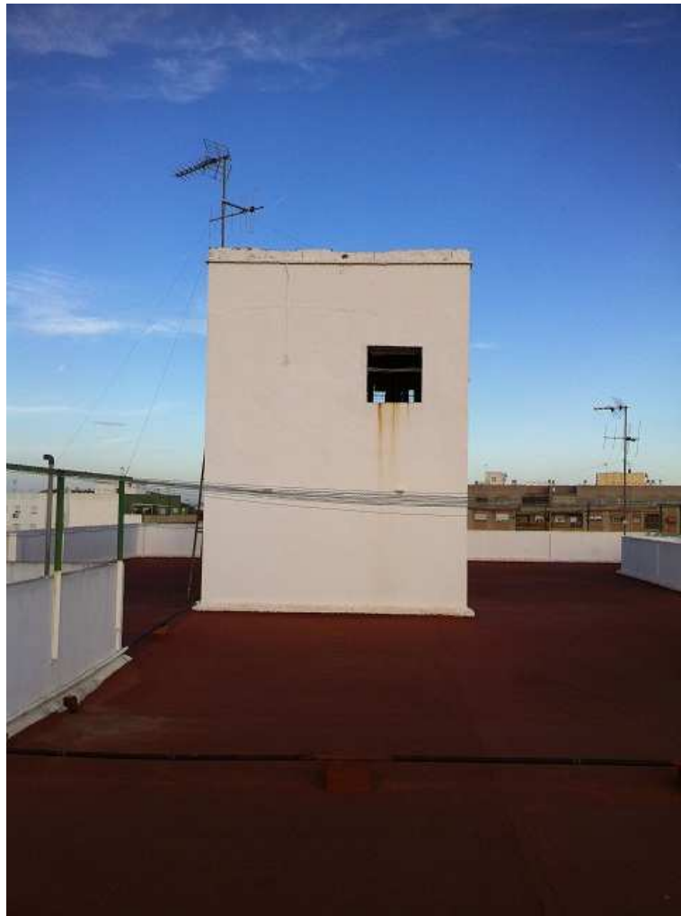
Figura 18. Casetón del ascensor y acceso a cubierta
