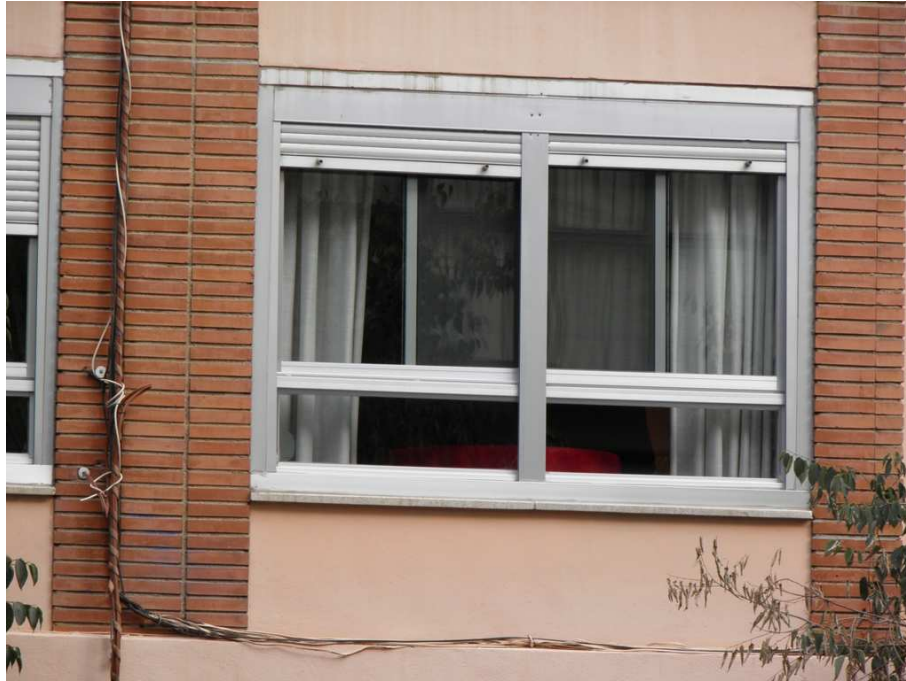
Figura 16. Carpintería exterior de la fachada principal (tomada el 04-11-14)
