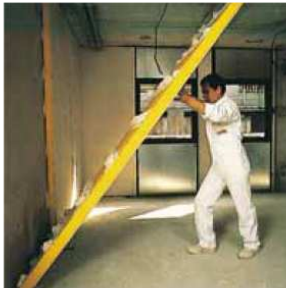
Figura 23. Colocación de trasdosado interior
