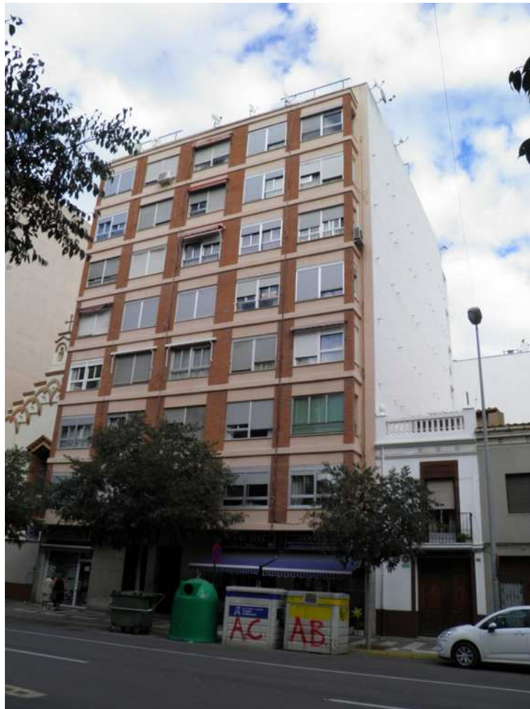
Figura 11. Fachada lateral orientada Sur (tomada el 04-11-14)
