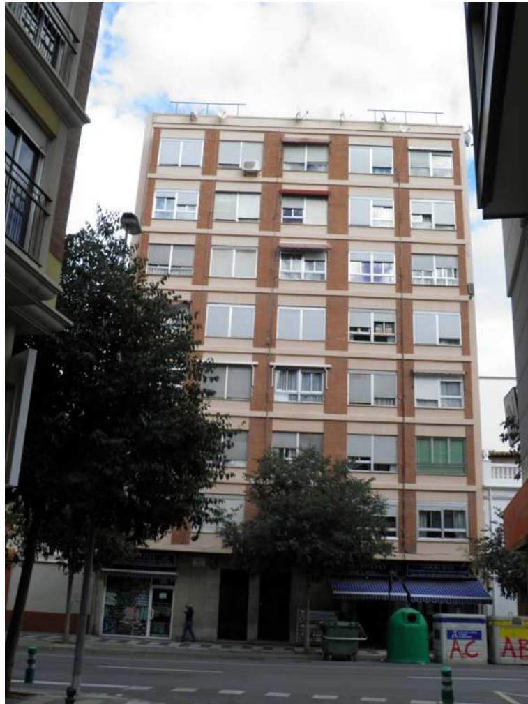
Figura9. Fachada principal, orientación Oeste (tomada el 04-11-14)
