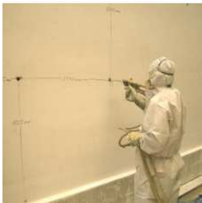
Figura 22. Imagen de la aplicación de PUR en cámara (Fuente: ATEPA, Asociación Técnica de Poliuretano Aplicado)
