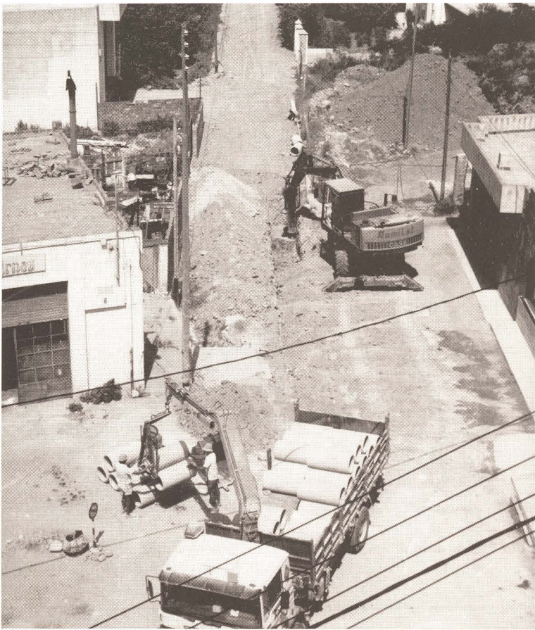
Se colocó el alcantarillado en el camino Carreró. Foto: A. Alcázar
