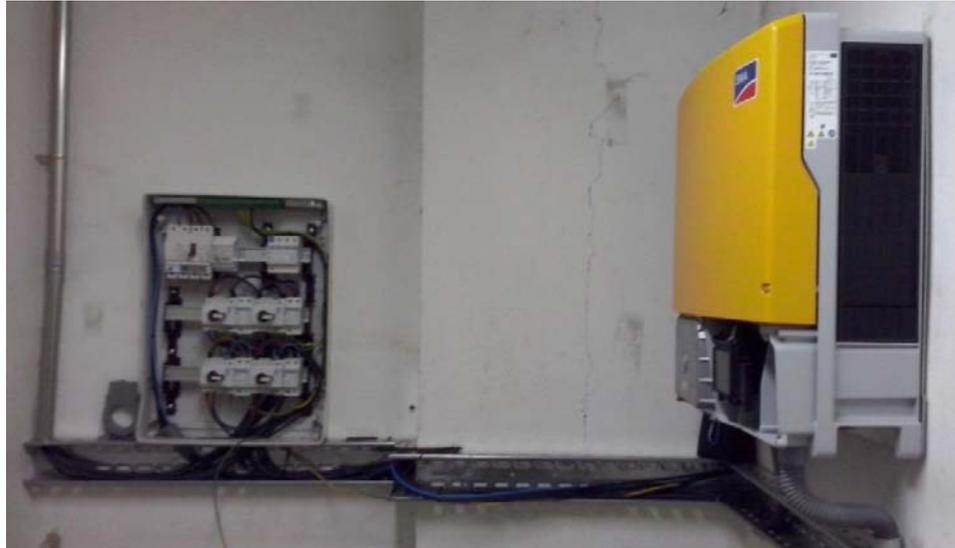
**Ilustración 27. Inversor y cuadro eléctrico de CC y AC**
