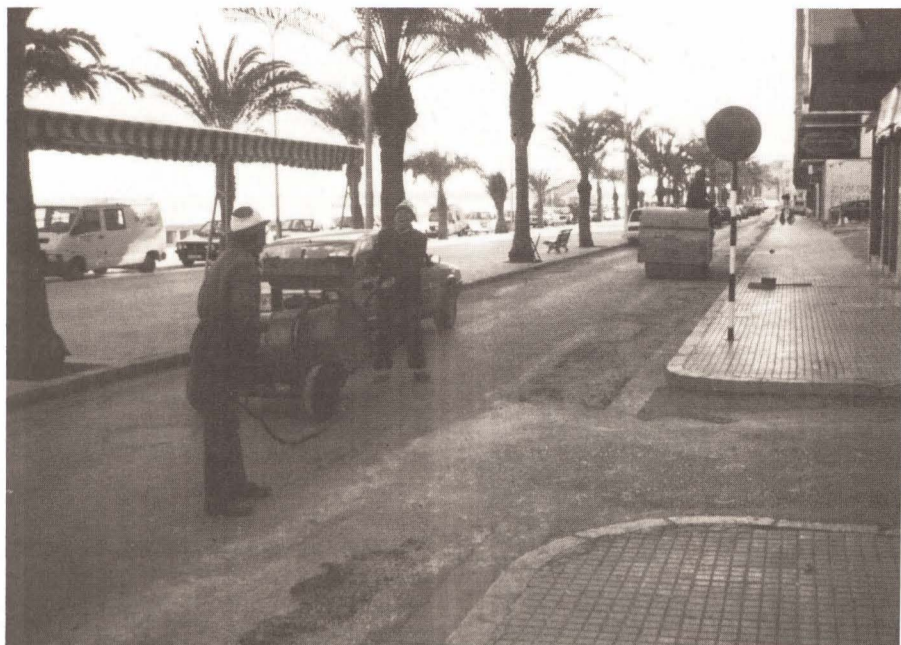
Obras de acondicionamiento del firme del paseo. Foto: Reula
