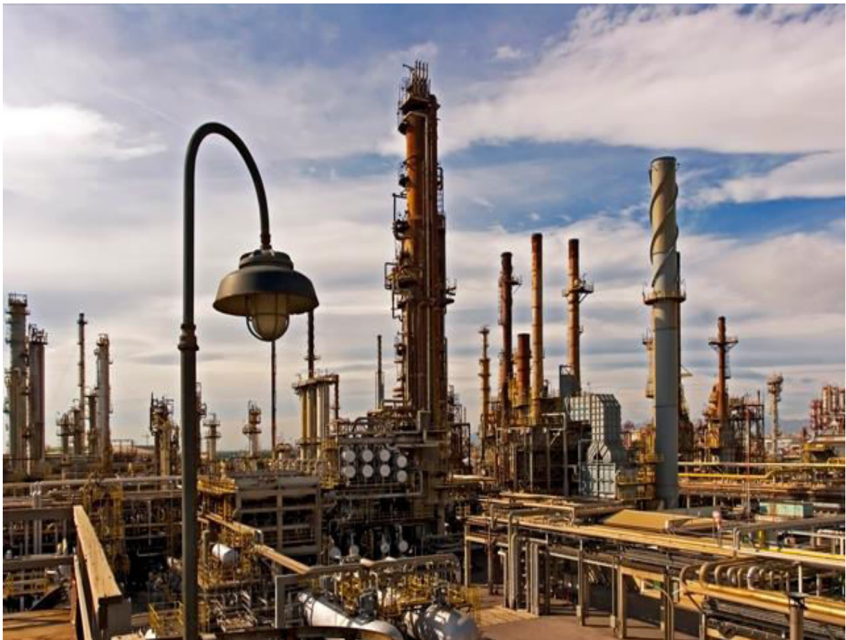
Ilustración 1.7. Torre de destilación atmosférica de la refinería BP Oil Castellón
