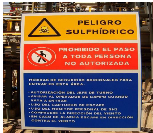
Ilustración 5.1.1.1. Cartel de aviso de presencia de H 2 S
