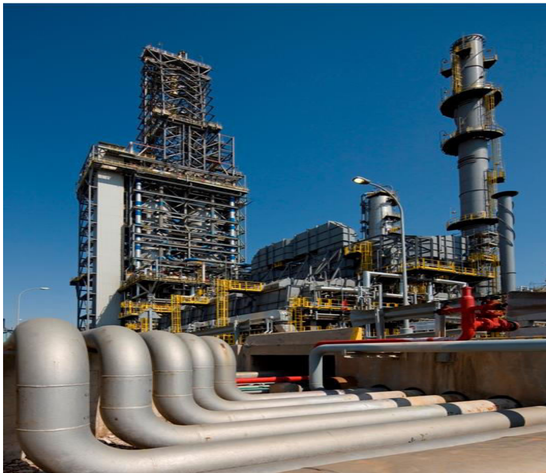
Ilustración 1.15. Imagen de la instalación de Coquer de la refinería de Castellón
