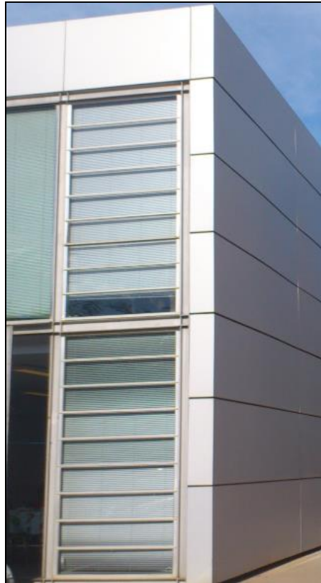
Figura 16: Cerramiento fachada alucobond
