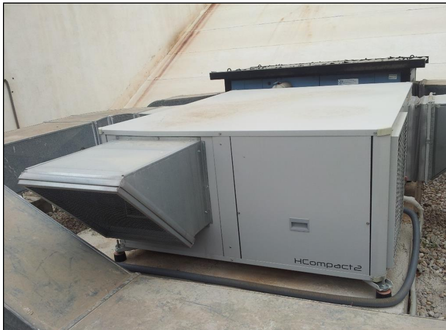
Figura 31: Unidad compacta CIATESA
