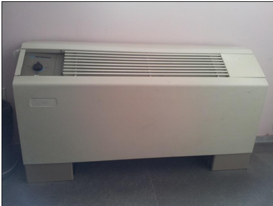
Figura 34: Fan Coil TERMOVEN FL-200
