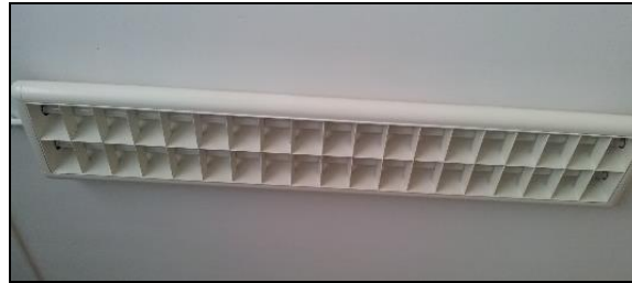
Figura 25: Pantalla formada por tubos fluorescentes T8 2x58W
