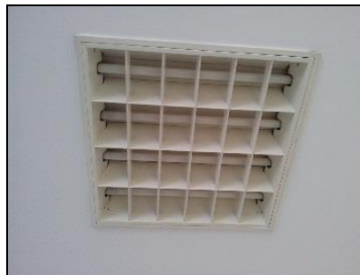
Figura 26: Pantalla formada por tubos fluorescentes T8 4x18W
