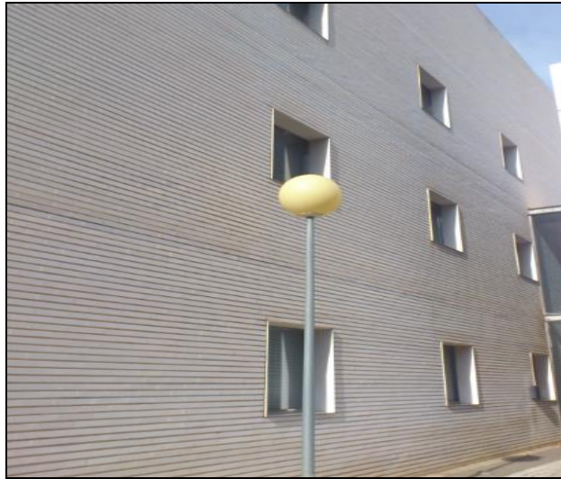
Figura 10: Cerramiento fachada caravista
