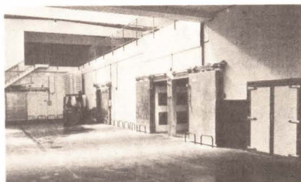
Vista exterior del túnel y cámaras para pescados
