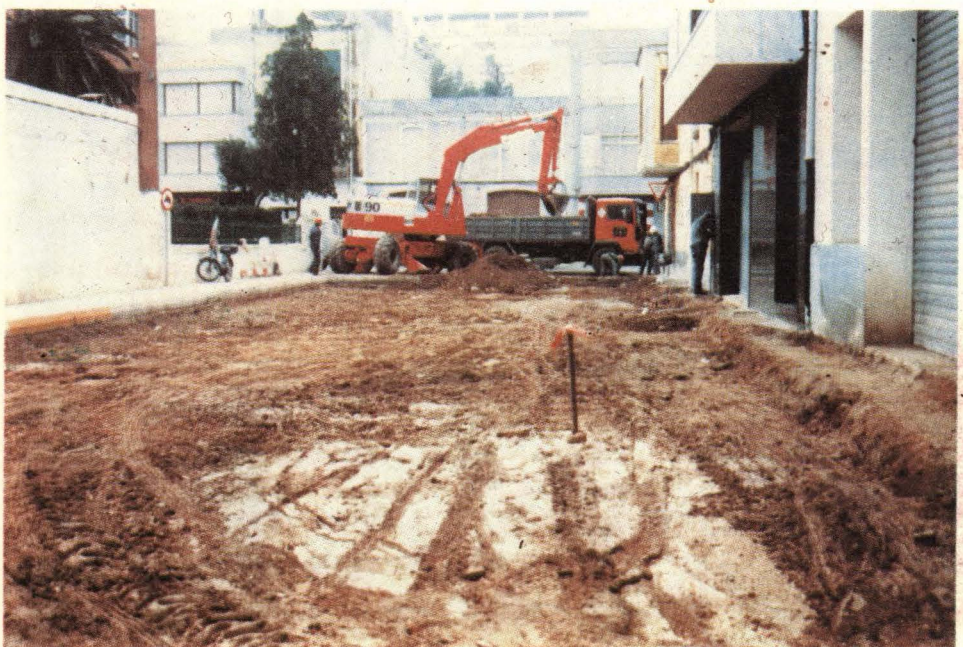
Han empezado las obras de Urbanización de la Calle Hospital. Foto: Reula
