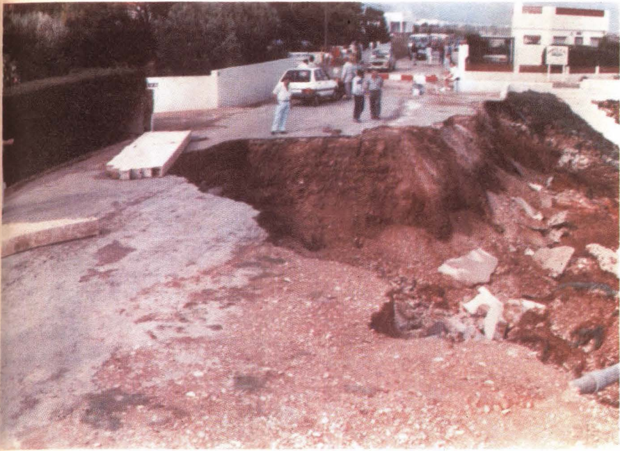
Carretera Zona Turística Nord
