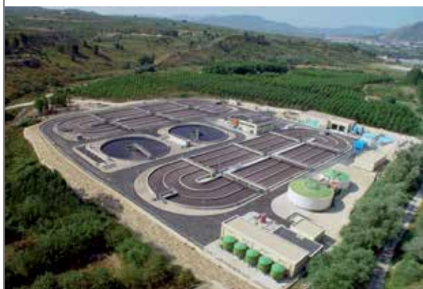
Figura 1. EDAR Font de la Pedra.
