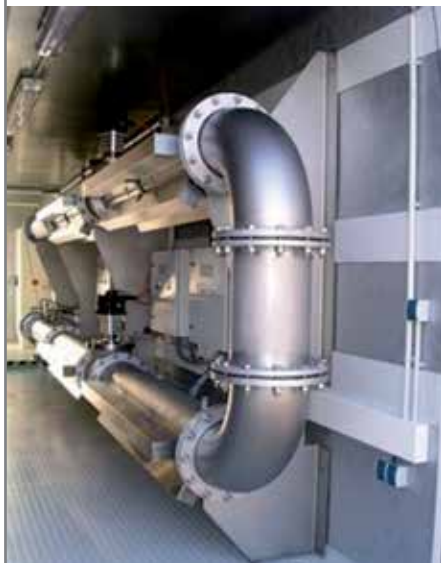
Figura 3. Planta piloto de ozonización y ultrasonidos.
