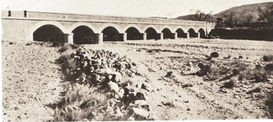
Grupo de pontones en la carretera de Torre-Embesora a Albacácer
