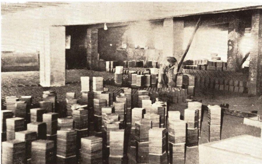
Nave de secado de piezas de una fábrica de azulejos de Onda
