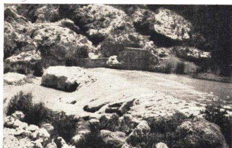
Presa de la BARCHILLA construida en el año 1401, por Doña María de Luna, Señora de Segorbe, para recoger las aguas de la acequia NUEVA
