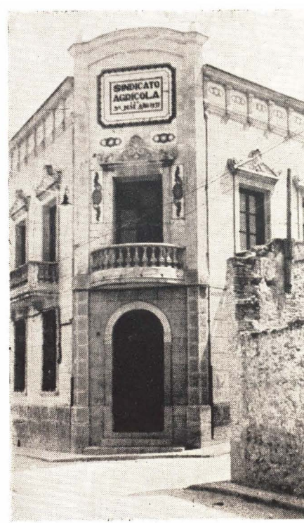
Edificio propiedad de la Caja Rural de Crédito y Ahorros de la Cooperativa Agrícola de San José de Alcora
