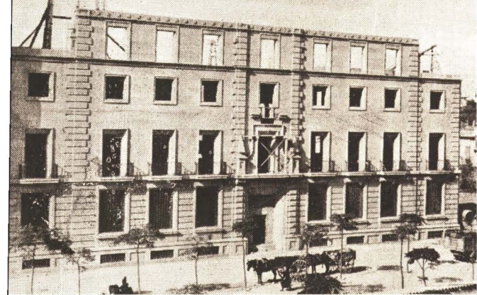
Estado actual de las obras del nuevo edificio para Delegación de Hacienda de Castellón
