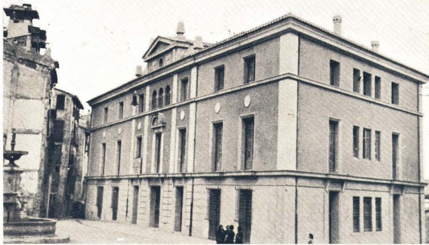
Edificio del Ayuntamiento
