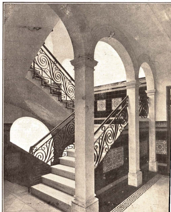
Detalle de la escalera del domicilio social
