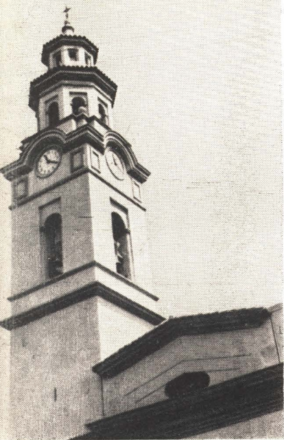
Nueva torre-campanario de la Iglesia Parroquial
