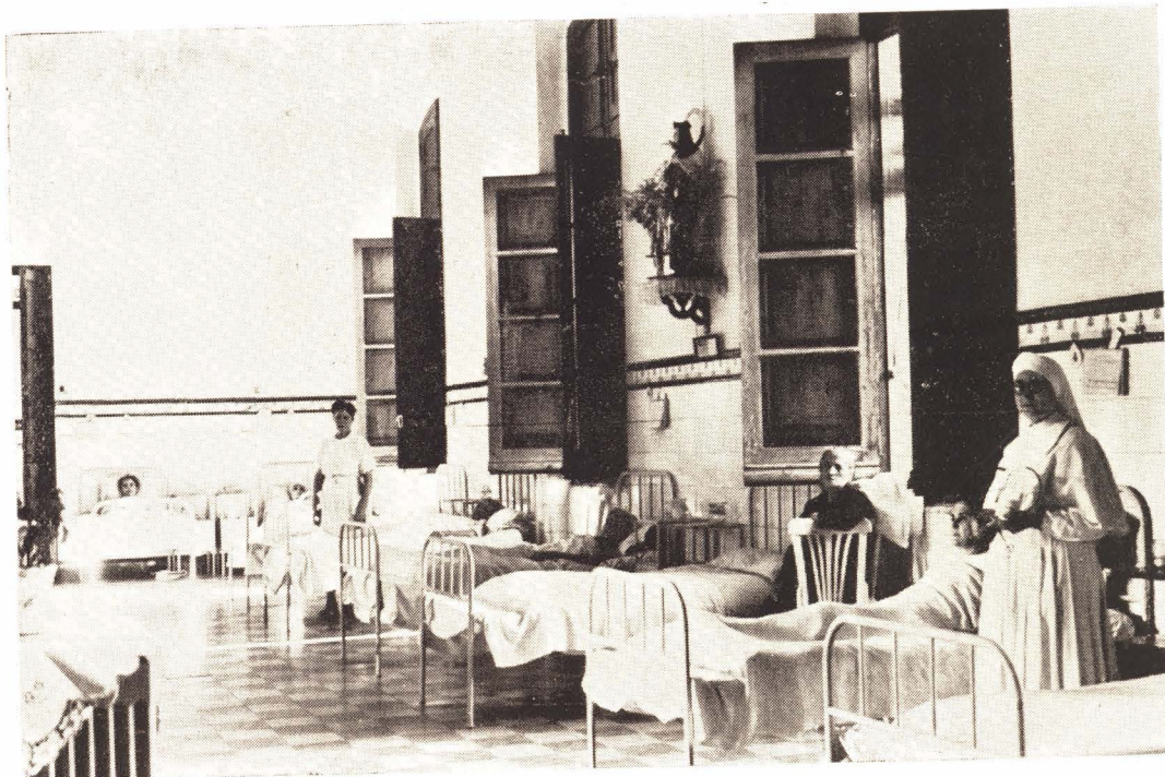
Sala de mujeres del Hospital Provincial
