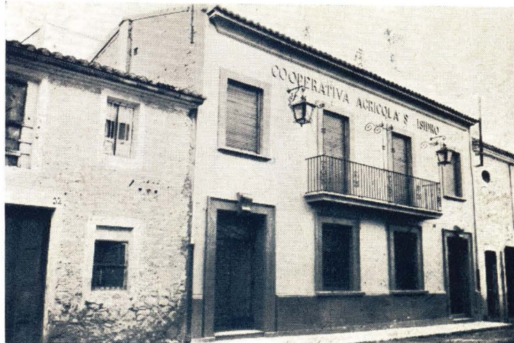
Fachada del edificio de la Cooperativa
