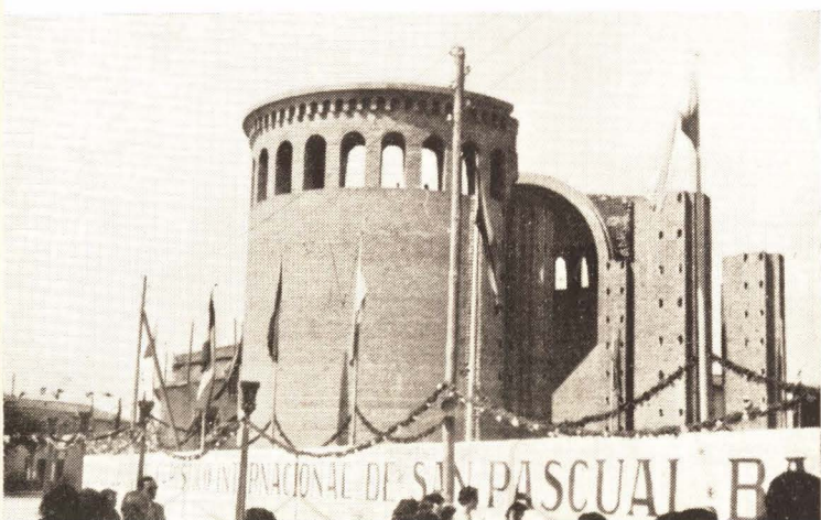
Estado actual de las obras del templo de San Pascual
