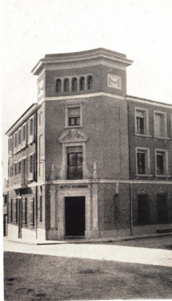
Edificio propiedad de la Mutualidad Segorbina en el que tiene instaladas sus oficinas
