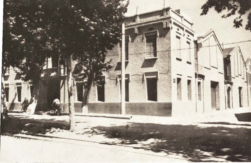
Edificio y almacenes propiedad de la Entidad, en Hermanos Bon 33
