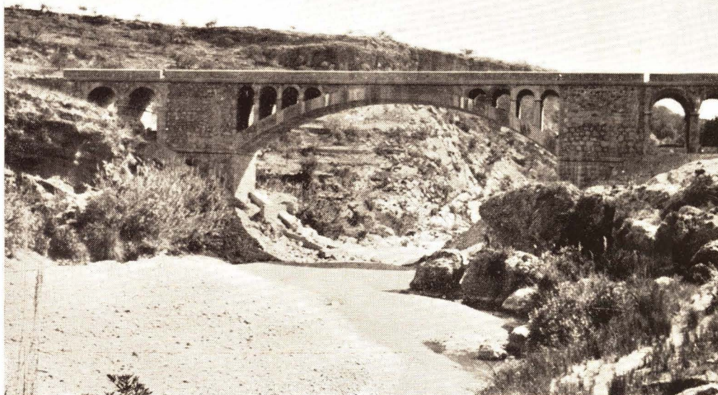
Puente sobre el Mijares en la carretera de Alcora a Onda
