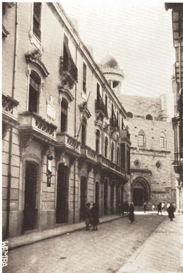
Edificio social de la calle de Caballeros
