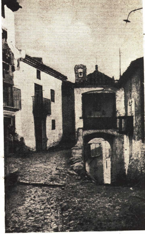
Portal de San Roque
