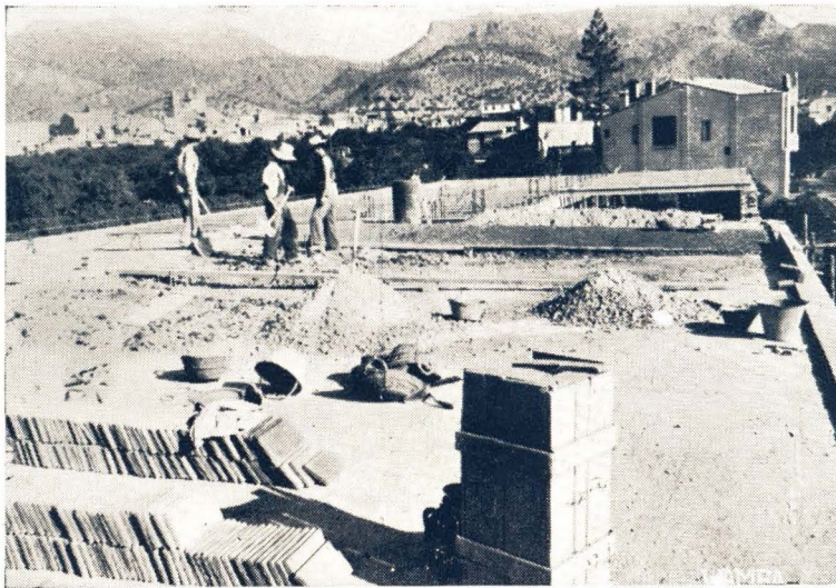
Obras para el edificio del Instituto Laboral
