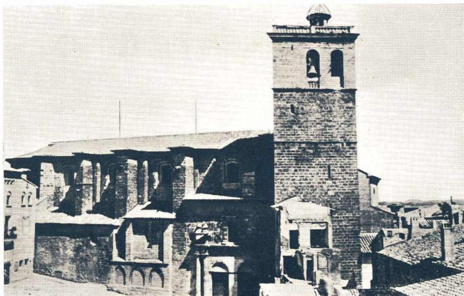
Fachada y Campanario ↓
