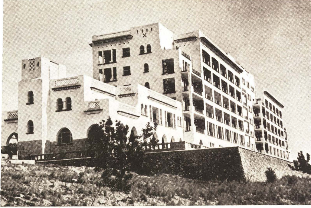
Edificio del Sanatorio antituberculoso
