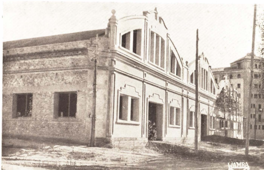
Edificio en construcción, propiedad de la Cooperativa Agrícola Arrocera de Castellón, para nuevos almacenes de arroz
